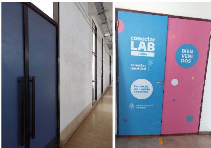
12 – VIDRIOS SALAS Y PUERTA SALAS (13)
