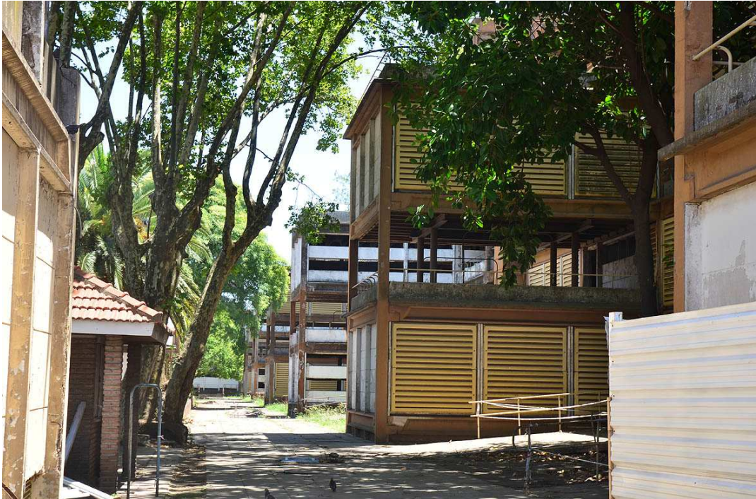
Foto 3: Fachada interna del edificio.
