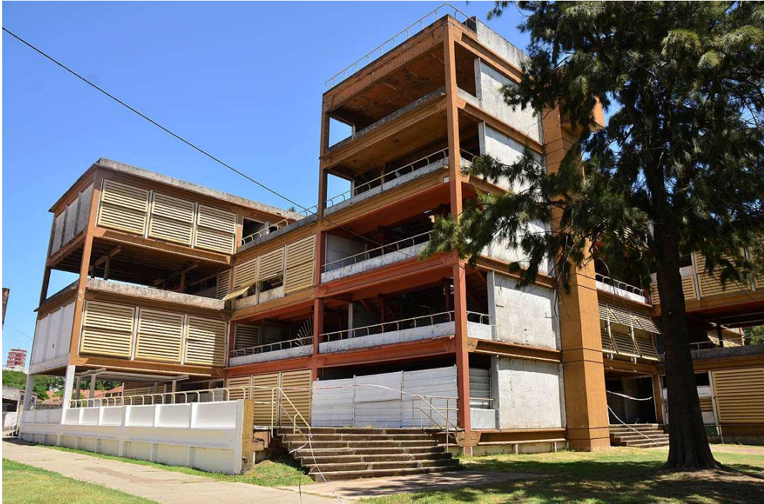
Foto 1: Extremo NE del edificio.
